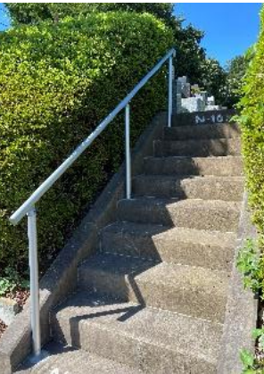
階段手すり J区画：9箇所 N区画：10箇所
